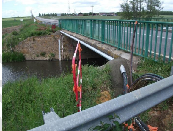
Passage de pont en encorbellement
