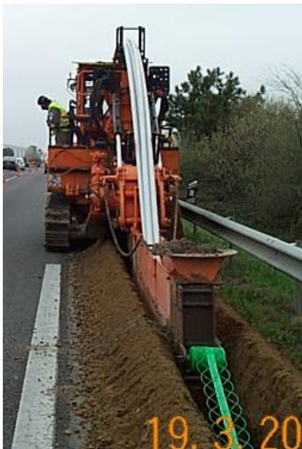
Pose en rive de chaussée
