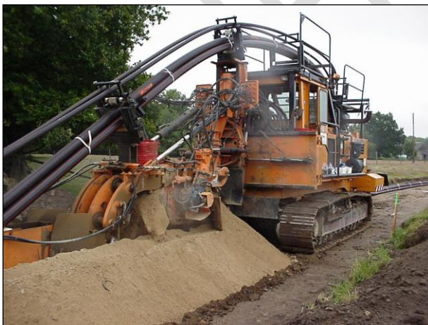
Pose simultanée du réseau et du grillage avertisseur
