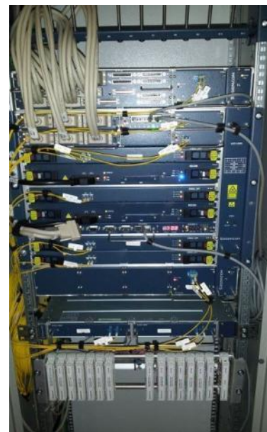
Figure 24 Équipement Sagem de Manantali - gros plan du système STM-64
