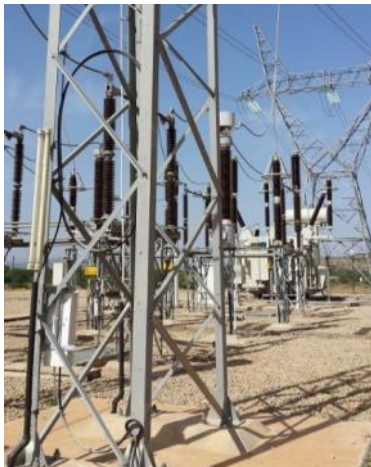
Figure 17 Boîte de jonction de Manantali vers Kayes (arrière)
