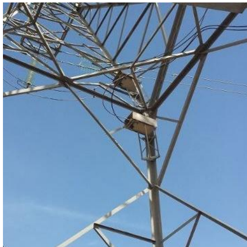
Figure 28 Boîtes de jonction de Dionfa Kourou
