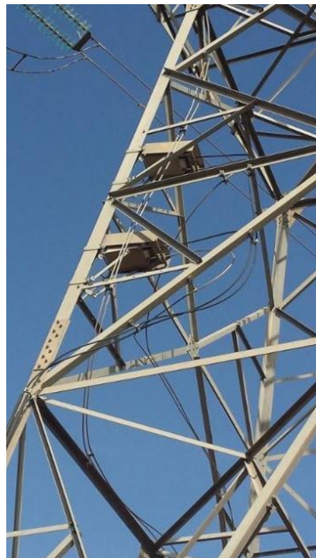
Figure 26 Boîtes de jonction de Kita
